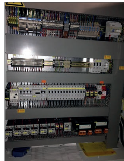
Pumpen- und Warmwasserumlauf sowie die autarke (MSR-Technik) Heizungs- und Lüftungsanlage wurden zusammengeführt
