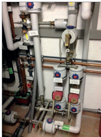
Pumpen- und Warmwasserumlauf sowie die autarke (MSR-Technik) Heizungs- und Lüftungsanlage wurden zusammengeführt
